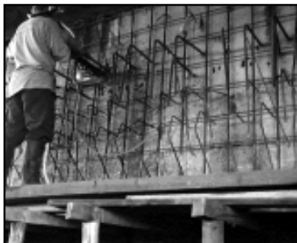
Foto 16 - Reforço de armadura
