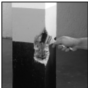
Foto 09 - Aplicação COMPOUND ADESIVO
