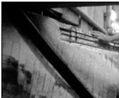
Foto 17 - Substituição de armadura
