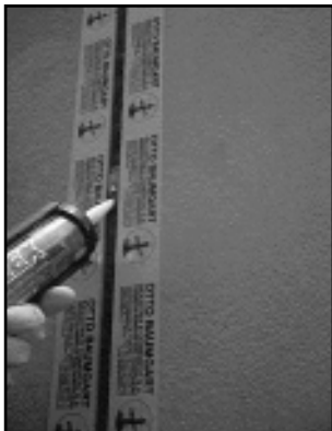
Foto 12 - Sequência de aplicação de mástique
