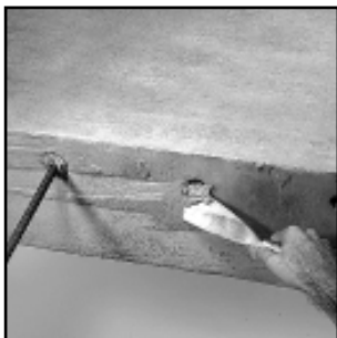
Foto 10 - Aplicação COMPOUND ADESIVO TIX
