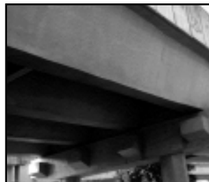
Foto 20 - COBERIT ACRÍLICO aplicado
