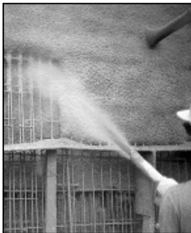
Foto 05 - Projeção de concreto
